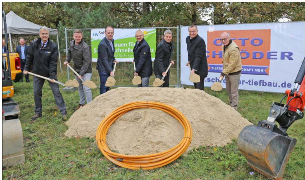
Erster Spatenstich: Der Breitbandausbau in den sogenannten „weißen Flecken“ in den Soltauer Ortschaften hat begonnen. Foto: dl
